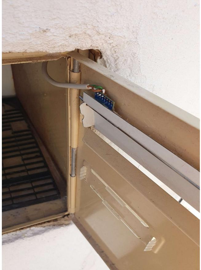
Les fils de liaisons ont été préalablement soudés, puis un vernis de protection (**CFG Plastifiant Spray film protecteur transparent Imperméabilisant 400 ml Plastificateur**) appliqué sur les deux faces du circuit.
